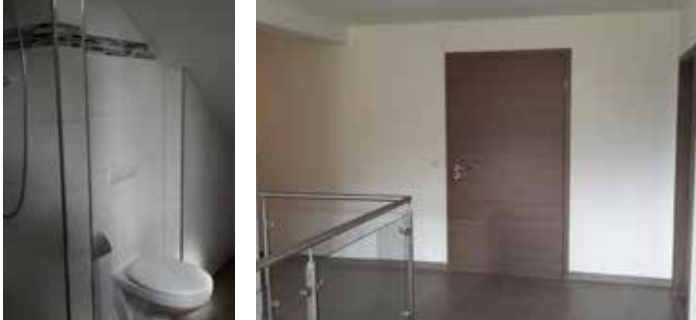
Foto 5/6/7: sanierte Innenräume des Rodler-Treffs Eckartsberga
