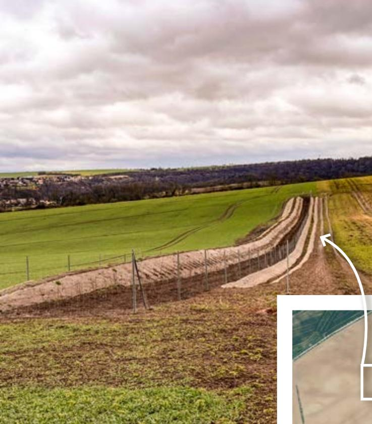
Damit der Boden auf dem Acker bleibt: 250 Meter langer, zwei Meter hoher und bepflanzter Wall (links). Dafür wurde eine bereits vorhandene Struktur genutzt (Luftbild). Mittlerweile wurde auch die weiter westlich als grüner Streifen erkennbare Verwallung verlängert und verbreitert.
