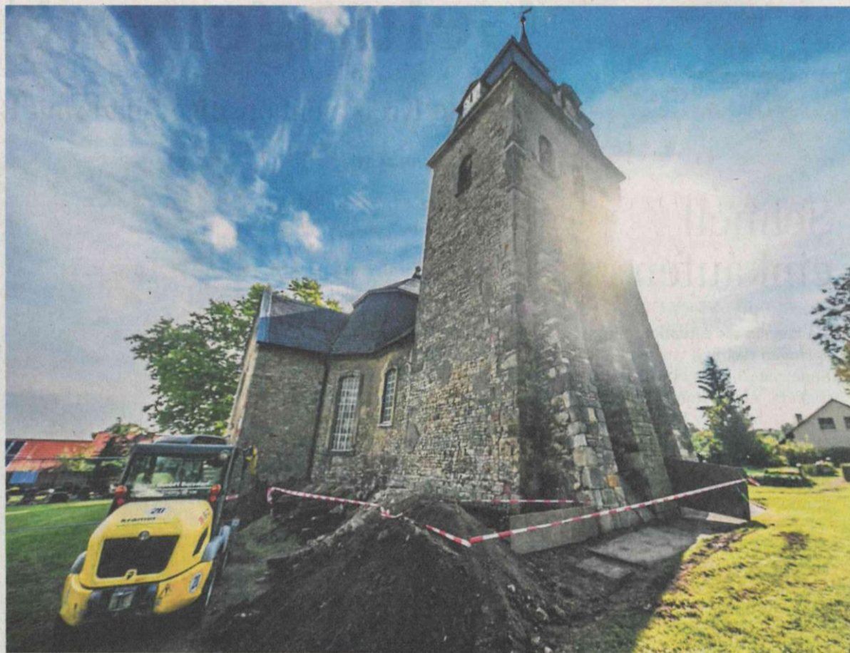
Die Kirche Krumpa muss trockengelegt werden. Dafür haben die Arbeiten begonnen.
