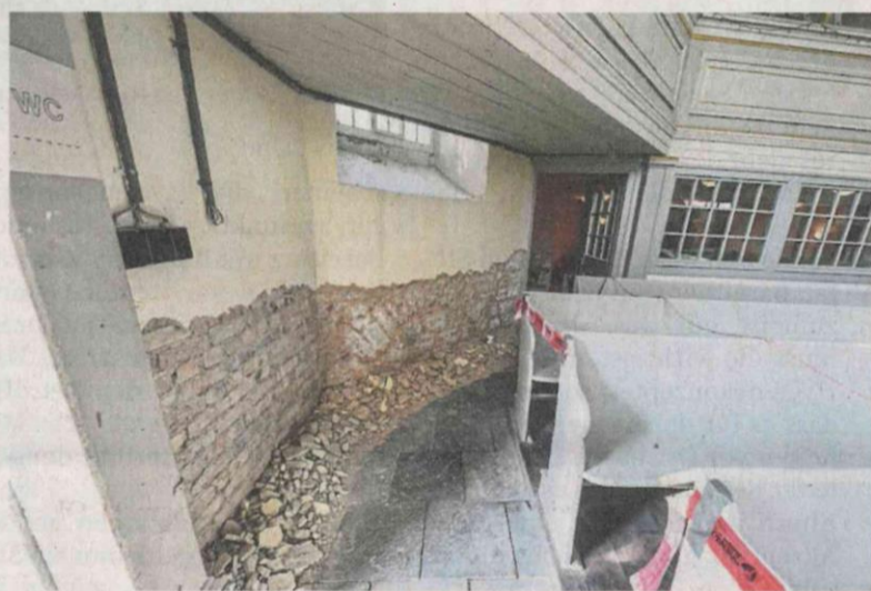
Der Sockelputz im Innenbereich wird ebenfalls erneuert.
