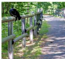
Ein Brückengeländer hat Besuch. FOTO: T. GERBANK
