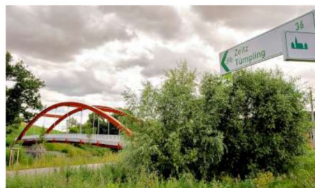
Die Farbe des Bogens der Saalebrücke bei Stöben (nahe Camburg) macht das Bauwerk auffällig. FOTO: T. GERBANK
