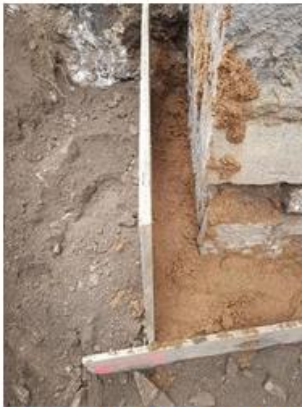
Abdichtung der Grundmauern
