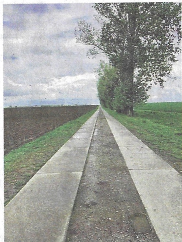
Weg im Süden Müchelns. Er könnte bald offizieller Radweg nach Freyburg werden. FOTO: D. DÜNSCHEL
