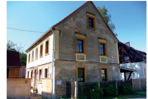
Fassade des Wohnhauses vor Sanierungsbeginn (Bild 8)
