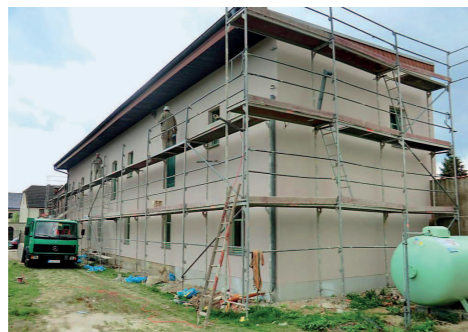
Fassadensanierung am Dorfgemeinschaftshaus Baunersroda (Bild 5)
