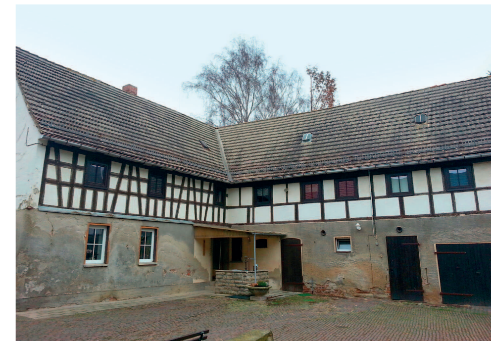
Fassadenansicht vor Beginn der Sanierungsarbeiten (Bild 11)
