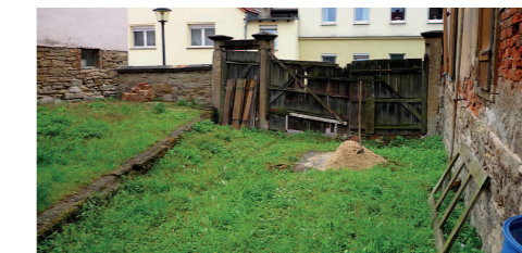
Hofeinfahrt vor Baubeginn (Bild 9)
