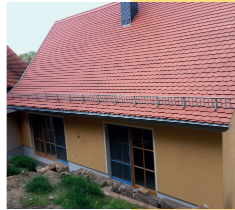
Die Scheune nach dem Umbau zur Wohnfläche (Bild 5)
