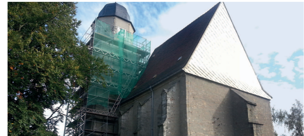
Fassadensanierung des Kirchturms in Profen (Bild 10)
